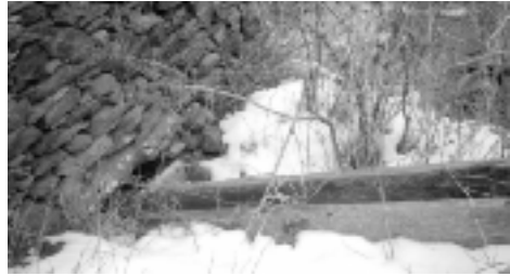
Imatge 2: Últim tram d'adducció en fusta al Mas del Solé. Noteu el pendent.
