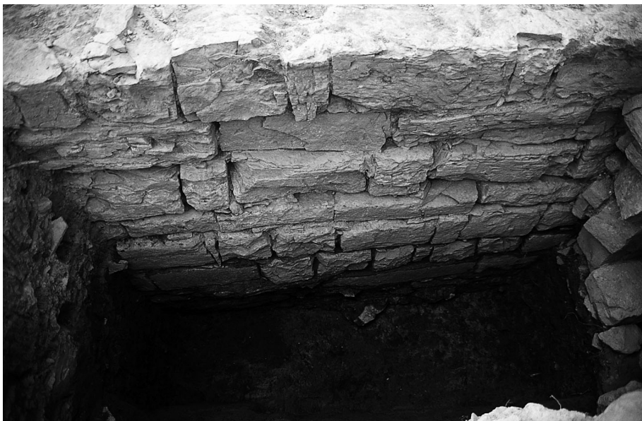
Fotografia 6. Sondeig practicat a la cara externa del mur est on s'aprecia la seva rasa de fomentació. En aquest punt el mur representa una alçada total de dos metres.
