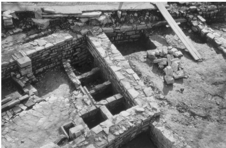
Fotografia 4. Vista de la relació estructural entre l'edifici medieval i la muralla de Pere III, a la dreta de la imatge.
