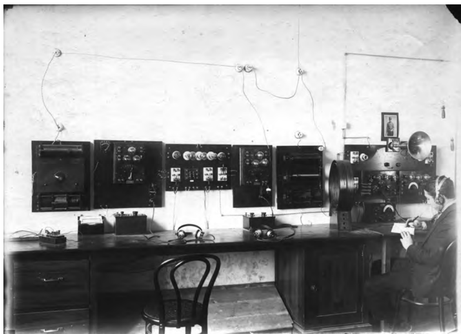
L'estació receptora de ràdio de l'SMC. La instal·lació fou feta íntegrament per Ramon Jardí.
