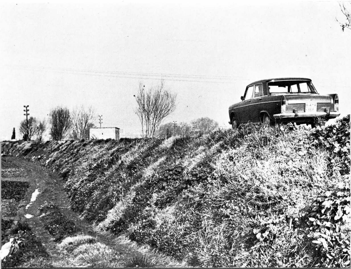
Terraplè de defensa contra les riuades del Llobregat. El Prat, febrer 1971.
